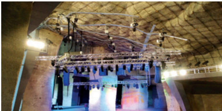
► A barlang mennyezetét védőháló biztosítja a kőhullás ellen
