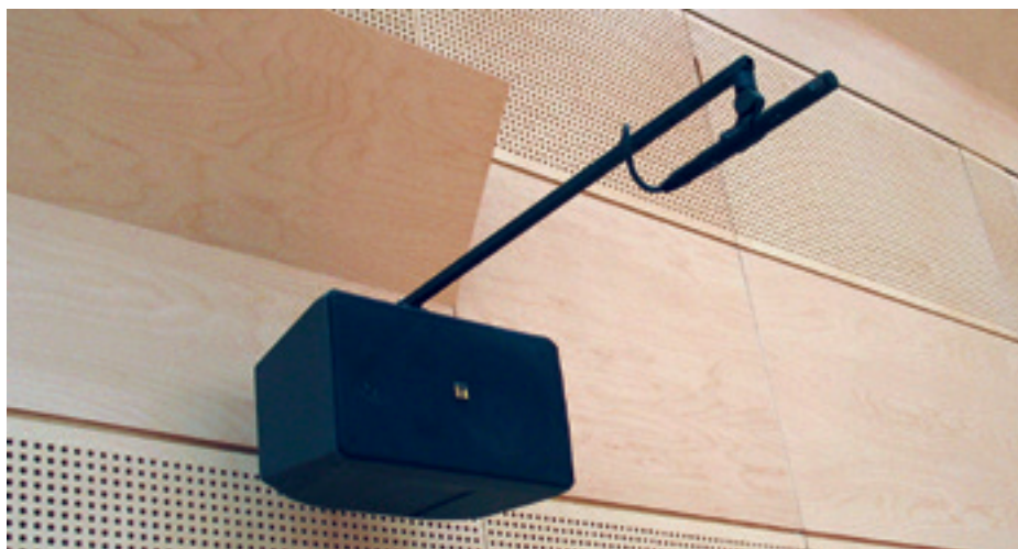
► A DCR teremakusztika-módosító rendszer egyik perifériája
