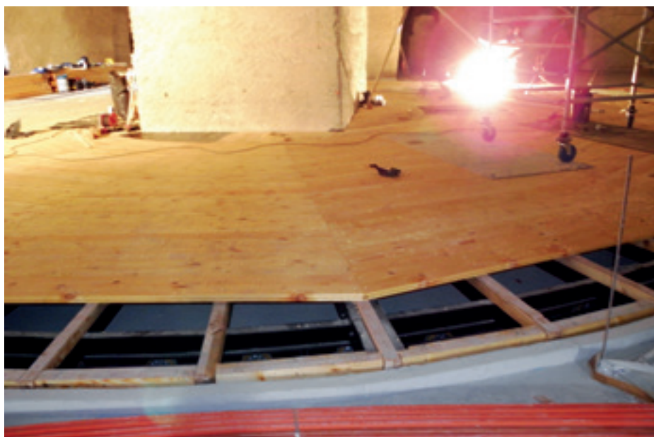
► A gyűrűs forgó szerelése a 19. jelű köoszlop körül
