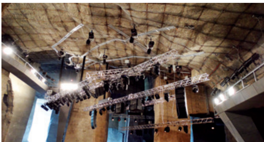
► Jól látható a befüggesztett front hangsugárzó rendszer
