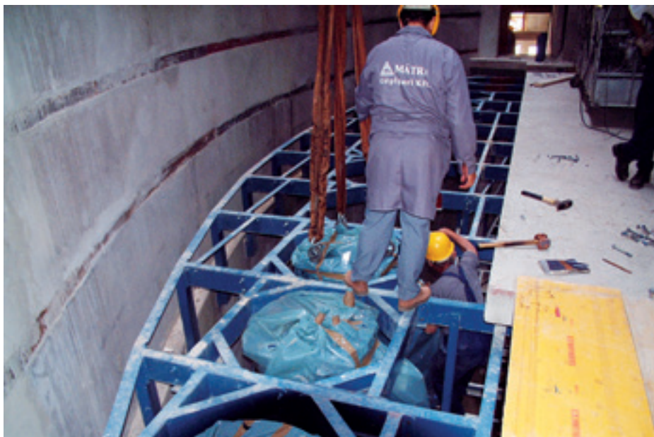
▶ A zenekariárok-süllyedő szerelése
