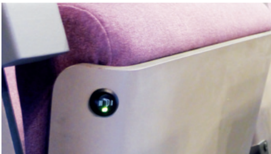
► A hajlított dekupon-lemez szerkezetű székek teflonszálás fűtése egyenként kapcsolható. Kapcsoló az előlap alján
