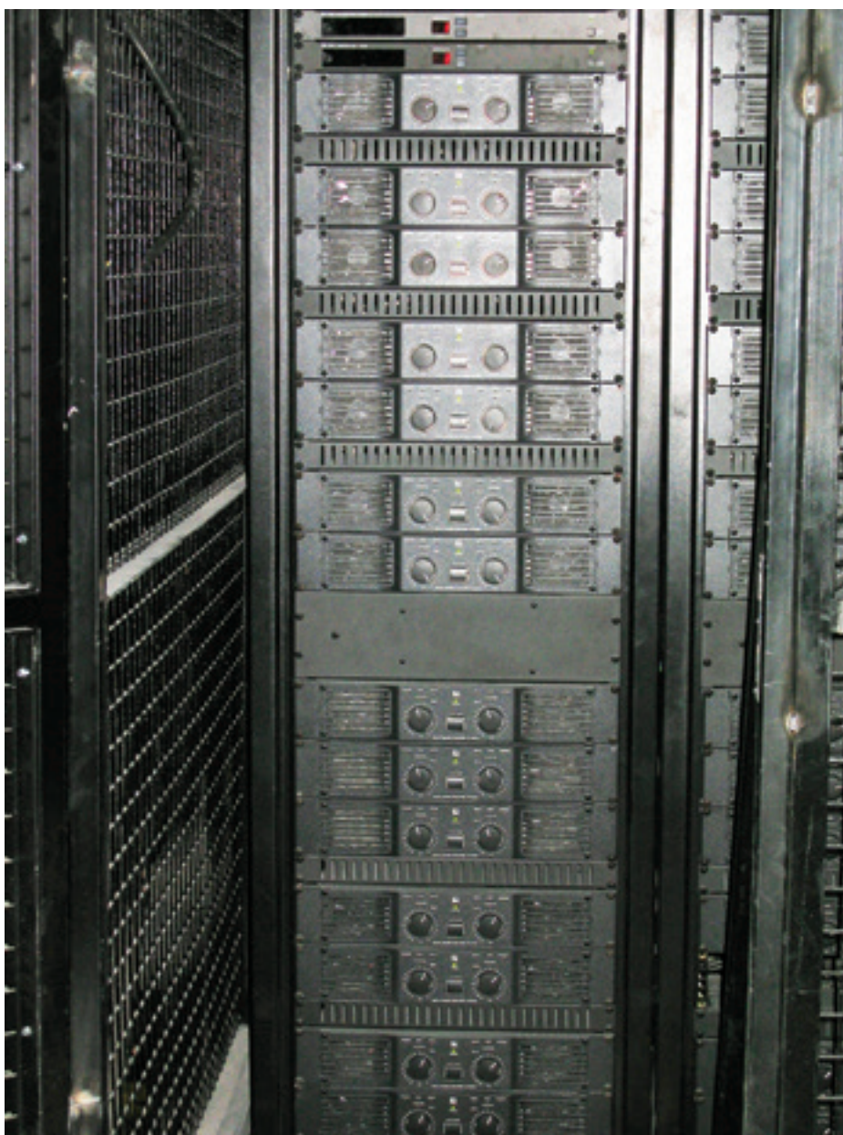
► A DCR teremakusztika-módosító rendszer végerősítő szekrénye
