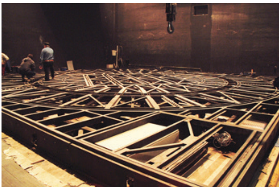
► A forgószínpadkocsi szerelése
