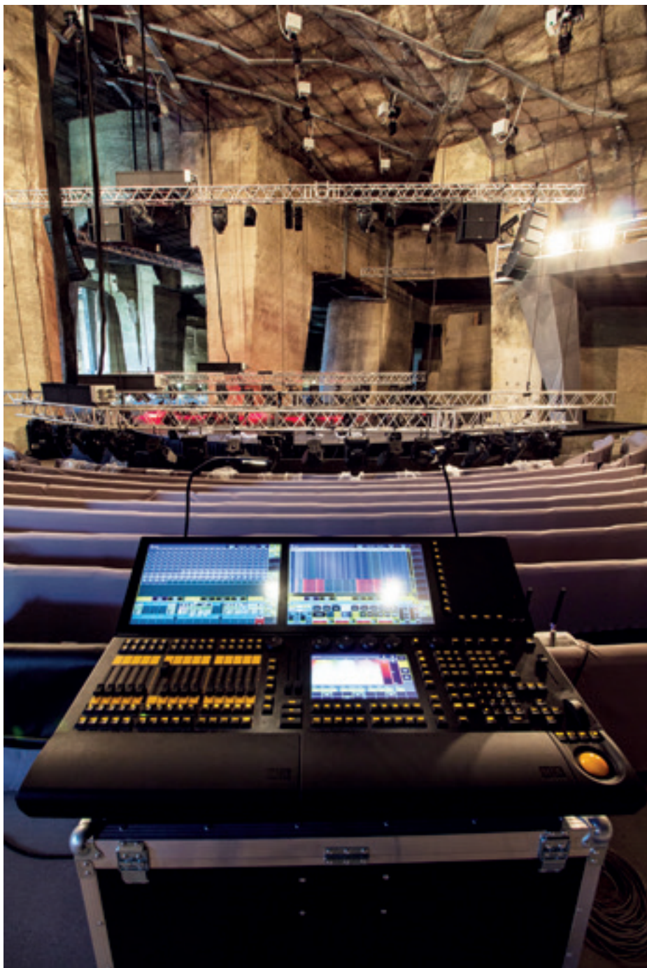
► Vezérlőpult a leeresztett világítási tartókkal és DMX-csatlakozópontokkal
