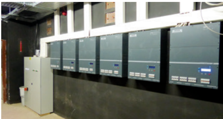
► Az új dimmerszekrények a falra simulnak
