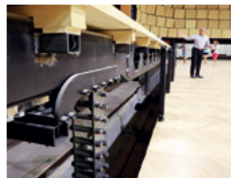
► A zenekari süllyedő Serapid emelőszerkezete
