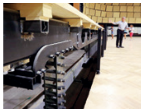
► A zenekari süllyedő Serapid emelőszerkezete
