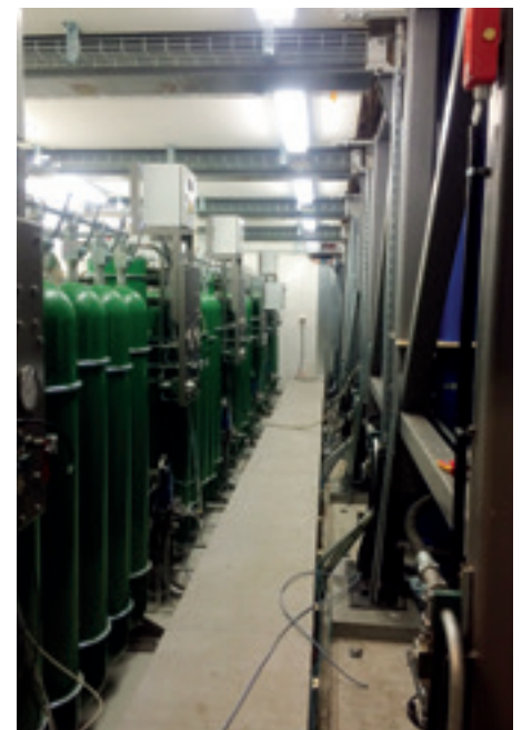
► Hidraulikus nyomástárolók: a berendezés halkan és nagyon precízen működik
