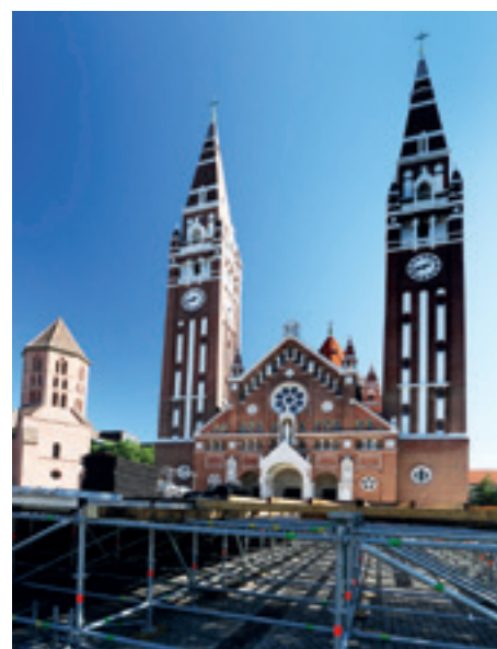
► Épül az előrehozott színpad szerkezete
