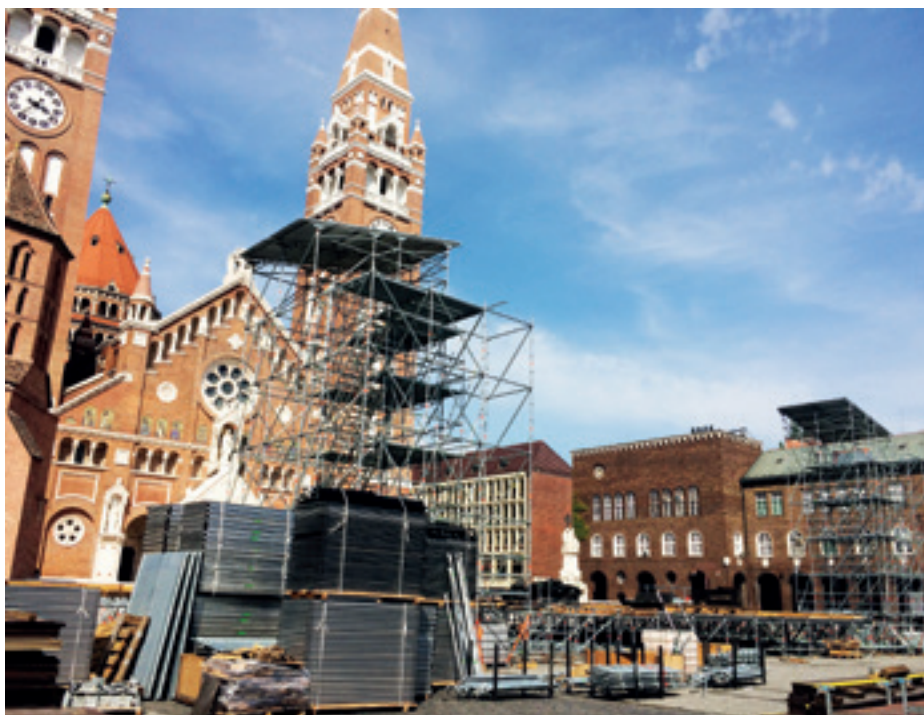
► A színpadi tornyok építése
