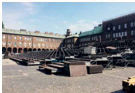
► A nézőtéri tribün építése
