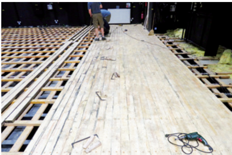
► Fesztivál Színház, főszínpadi padló lerakása a kettős párnafarendszerrel
