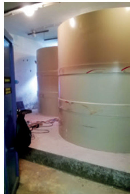
► 3. Záportartályok a pincében (a pincében, két egymás melletti helyiségben fértek el a tartályok, 5 db, összesen 53,3 m 3 víz tárolására)
