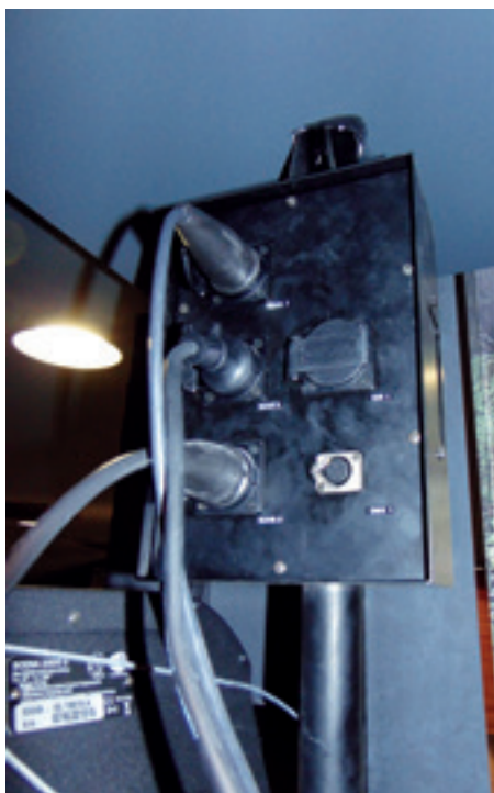
► 3 húzott, 1 direkt, 1 DMX csatlakozó a csőoszlopon
