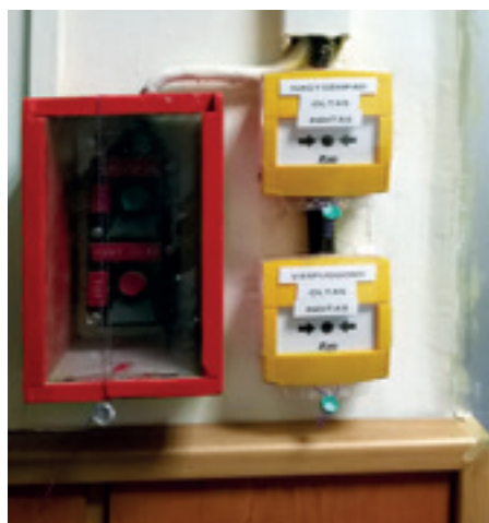
► 9. Indítógombok a folyosón és a színpadon (a rendezői bal oldalon)
