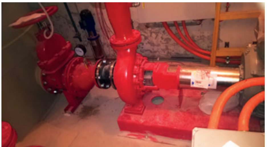
▶ 2. A fő- és tartalék szivattyú (két teljesen egyforma gépegység, a kettős biztonságért)
