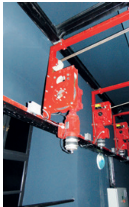
► A felsőgépezet hajtásegységei, közöttük a beépítésre váró tér
