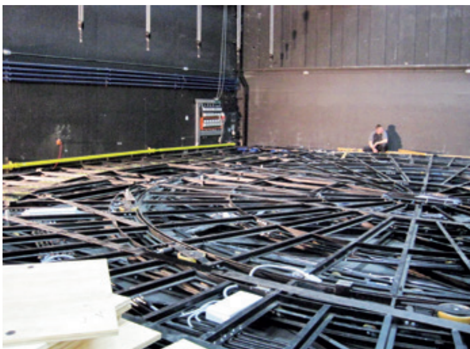
► A hátsószínpad-kocsi a gyűrűs forgószínpaddal. Három részre bontva tárolható a hátsószínpad hátfalán.
