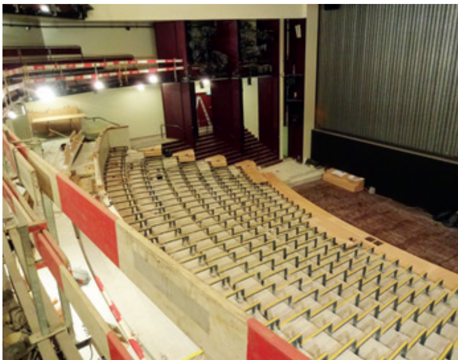
► A nézőtér új, lépcsős alsó szerkezete biztosítja a jobb látási viszonyokat
