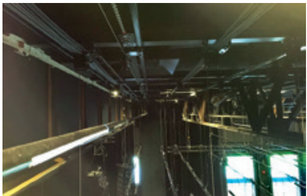
► A színpad mennyezetén vezetésben húzza láncos emelő a díszlettartó sodronykötelet
