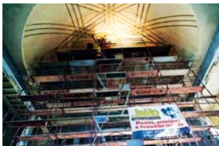
► Az eredeti kupola festésének helyreállítása
