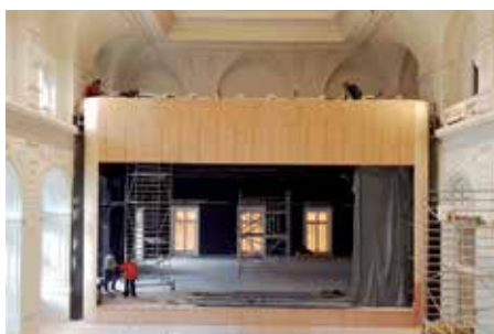
▶ Építik és szerelik a színpadot
