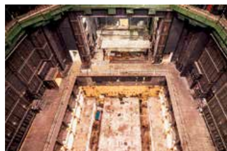
▶ Pillanatkép az Opera színpadának korszerűsítéséről: már kiszorították a régi süllyedőket.
