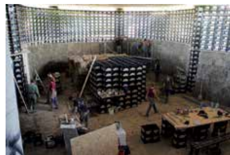
► Az S2 Színház építés közben
