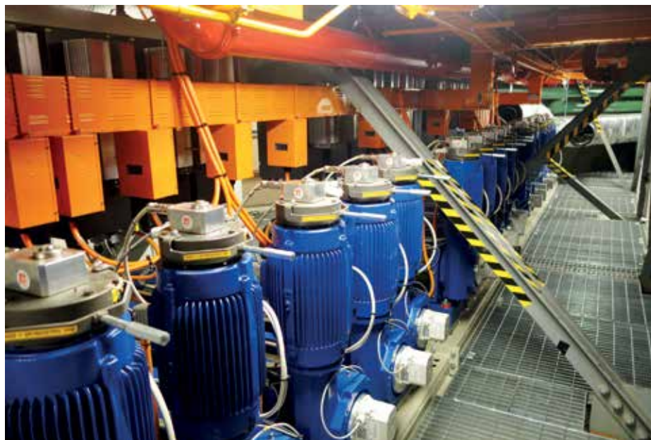
► Az új zsinórpadlás: a felsógépezet korszerű gépegységei telepítését a meglévő tetőszerkezethez igazították
