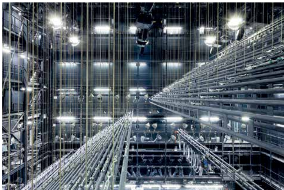
► Új lehetőségek és új kihívások: a díszlethúzóknak 20 cm-es távolsága és az 1,8 m/s nagy mozgatási sebesség precíz tervezést és a legnagyobb figyelmet igényli a napi üzemeltetés során
