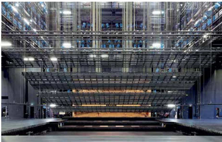
► Komplex logisztika: az új süllyedőrendszer és a felsőgépezet szcenikai és szállítási funkciót látnak el
