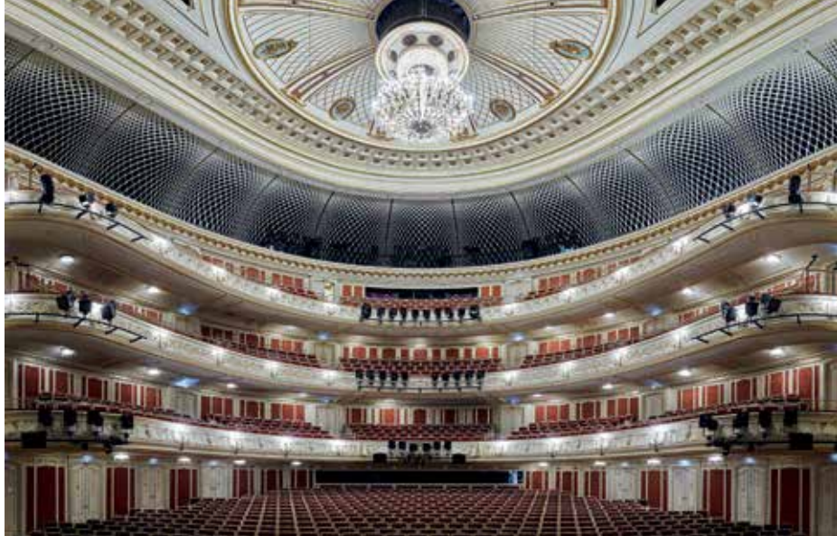
► Rejtett fényszóró-pozíciók a műemlék nézőtérén: a kazettás mennyezetbe a csillár körül világítási pozíciók vannak beépítve. A fotón leeresztett helyzetben lévő világítási gondola teljesen eltűnhet a mennyezetben
