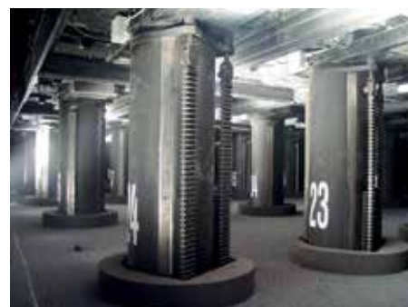
► A 72 db, 1x2 m-es süllyedő a Nemzeti Színház színpadán és a süllyedőket emelő lábak az alsószínpadon
