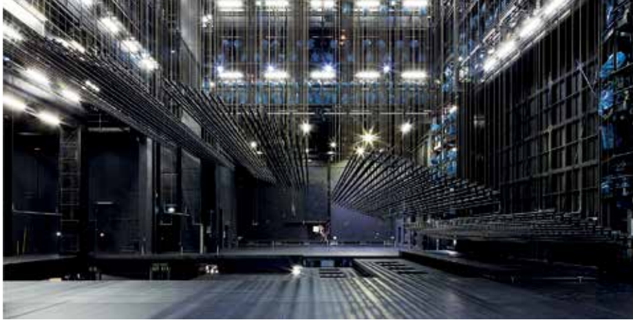
► Új belső struktúra: a színpad melletti területeket megnagyobbították. A színpadtorony megmaradt, de a nagyobb terhelés miatt megerősítették
