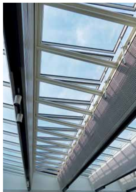
► Akusztikai elem is, ferdesikú, nyitható és árnyékolható üvegfelülettel, hangelnyelővel borított tartószerkezettel
