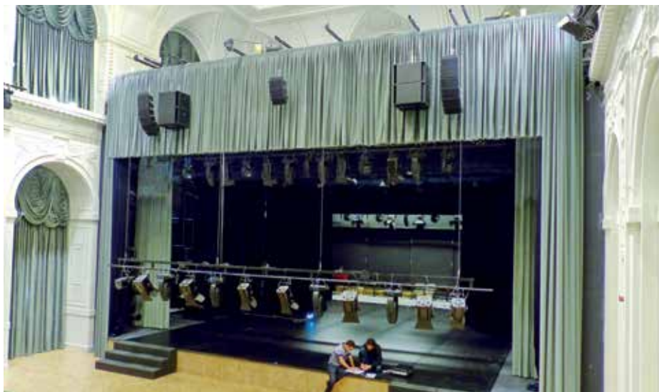
► Fronthangsugárzók a portál homlokfalán (a nézőtéri világítási tartó leeresztve)
