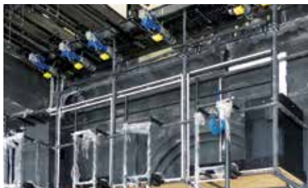
► A színpad munkakarzat szerelés közben
