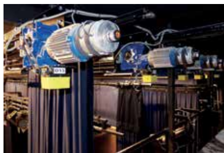
► Díszlethúzó hajtóművek a hátsó színpadon
