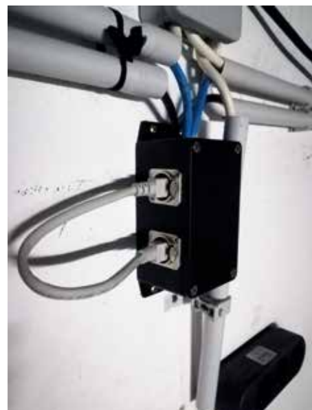
Új, mechanikailag sokkal stabilabb hálózati csatlakozópont a zenekari árokban
