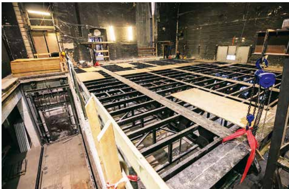
A hátsószínpad szerelése
