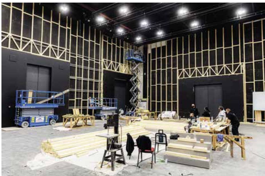
A Hevesi Sándor háziszínpad akusztikus falburkolatának szerelése
