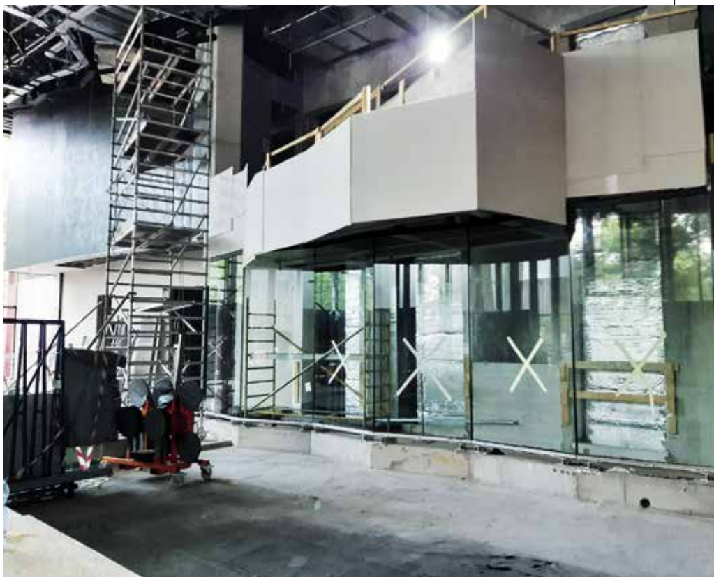
Rendezvényterem, felsőgépészet építése gurulóállványról
