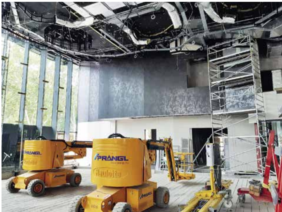
Emelőgépek és állványok a színpadi süllyeszték felett
