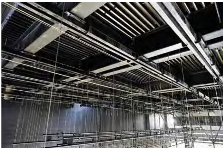
Zsinórpadlás alulról, ponthúzó sínekkel
