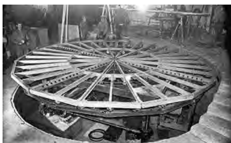
Az emelhető forgószínpad szerelés közben. A gumigörgős forgótárcsa sebessége 0,5–1,0 ford/perc volt
