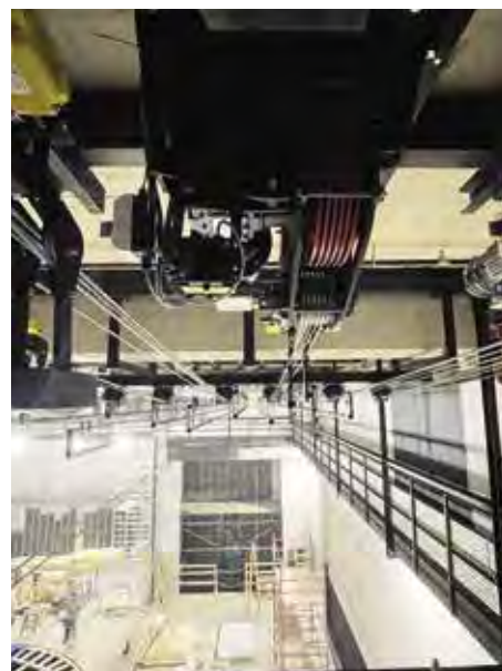
Hátsószínpadi rendszerek telepítés alatt
