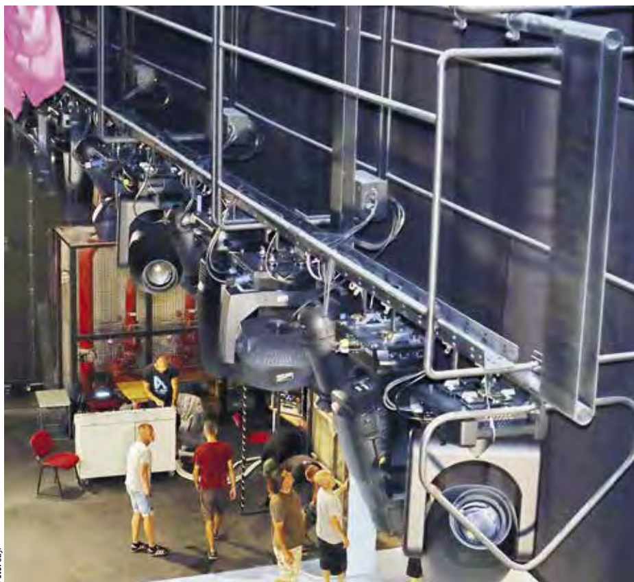
Gépi mozgatható világítási tartó a fényvetőkkel – Nagyszínpad
