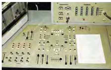
A színpadvilágítási áramkörök számára két előbeállítási és két csoportválasztási lehetőség volt. A színpadgépészeti berendezések vezérlése is a vezérlőasztalról történt
