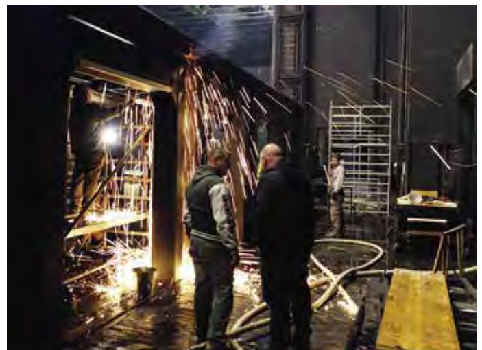
Régi süllyedők acélszerkezetének darabolása
