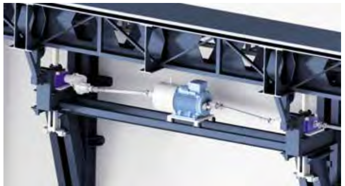
A hajtómotor beépítése
