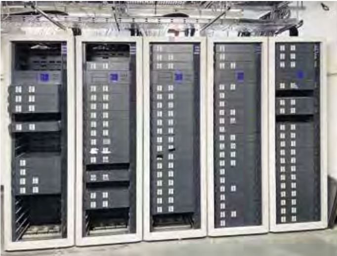
Operaház, dimmerkabinetek
