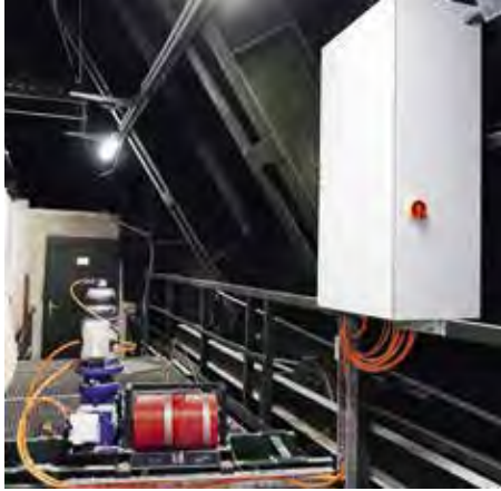
Vasfüggöny hajtásegysége villamos szekrénnyel
