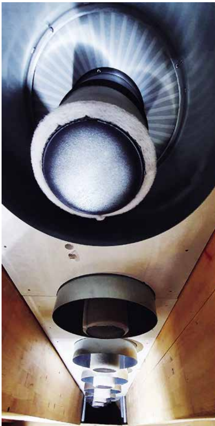
A nyomóteret és a zsöllyepadló közötti szellőzárás alulnézetből. A középső rész a szellőzésért felelős, a külső gyűrű az akusztikai csatolást segíti
