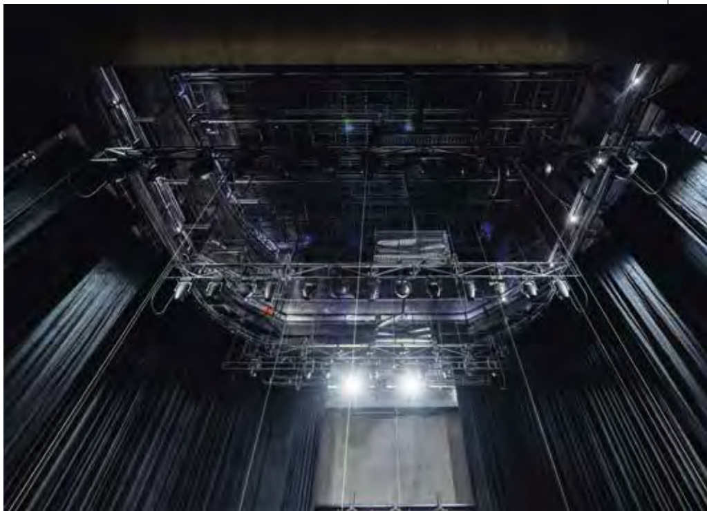
A felsógépészet az új rácsostartóval
