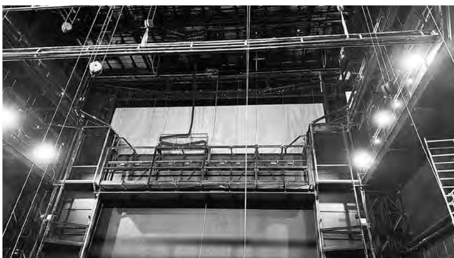
A vasfüggöny a felette elhelyezett tűzgátló függönnyel
