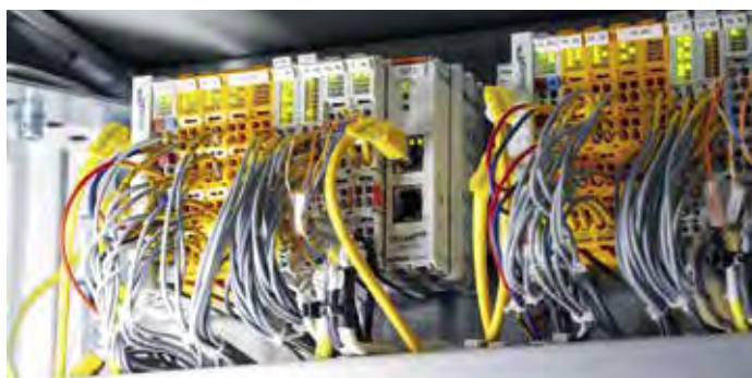
Vezérlőszekrényben elhelyezett EtherCAT-es I/O-szigetek: digitális ki-bemenetek, safety I/O-modulok és EtherCAT hálózati elosztók
