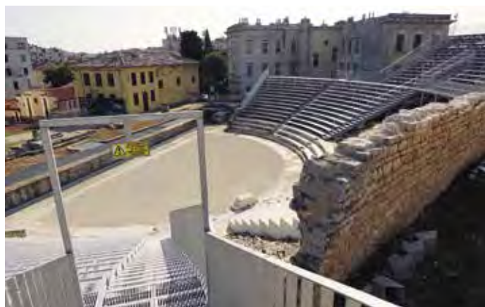
A nézőtér szintjeit összekötő lépcsőbe építették be az elektromos berendezéseket
