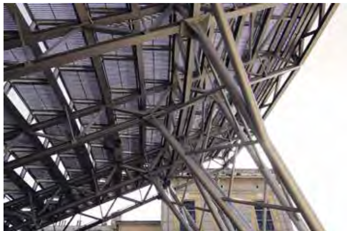
A nézőtér acél tartószerkezete
