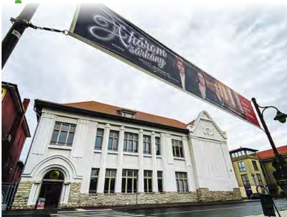
A NézőPont bejárata a színház felől
