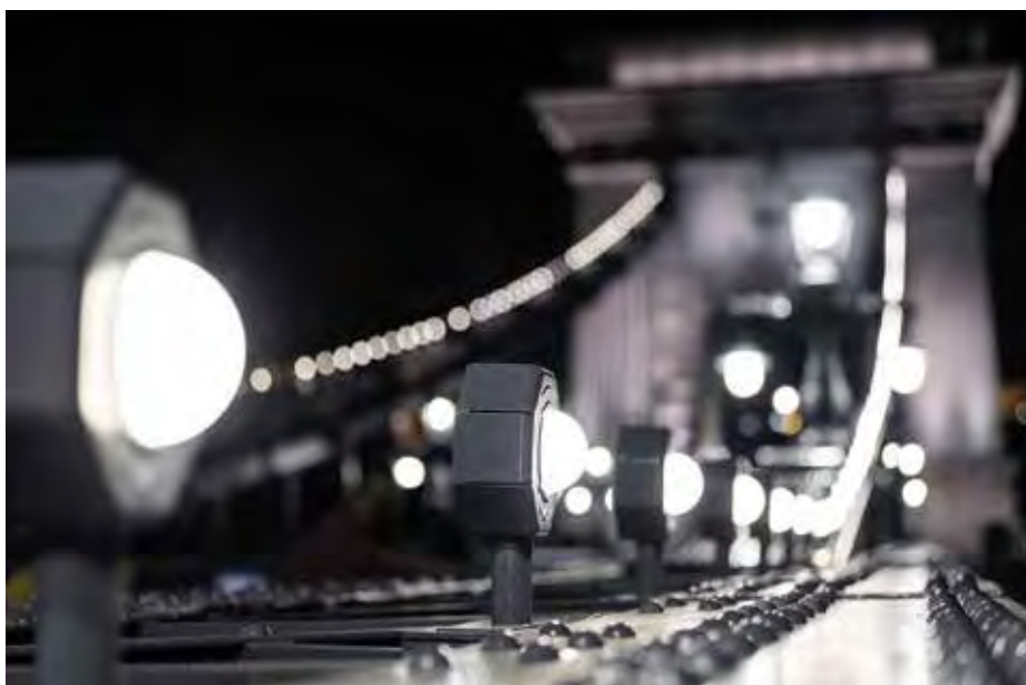
A fűzérvilágítás lámpatestjei egyedi védő és dekorációs célú burkolatot kaptak
