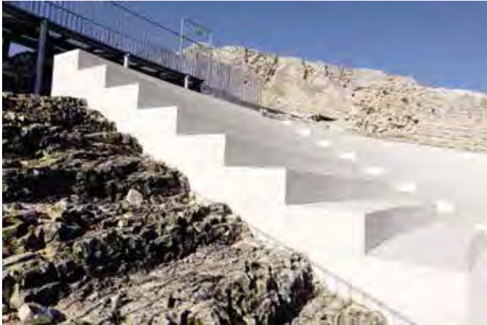
Az antik kövezetre illesztett fehér beton nézőtér
