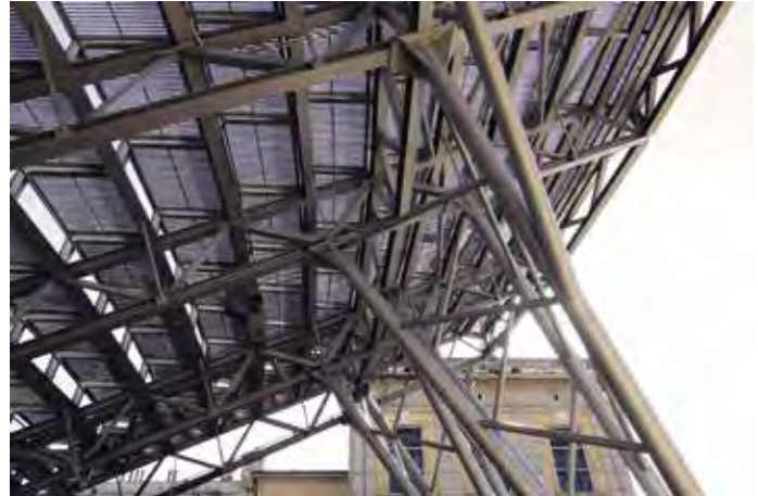
A nézőtér acél tartószerkezete
