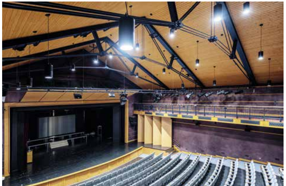
Az új lámpatestek a nézőtér fölött
