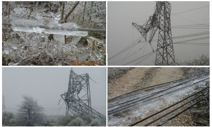
15. ábra: Az ónos eső okozta jéglerakódás, illetve a helyenként 6 tonna plusz terhelés miatt összerokkadt tartóoszlopok Gödöllő térségében. (MAVIR felvételei).
