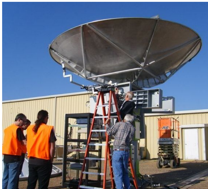
18. ábra: A negyedik radarállomás DWSR 2500C SIDPOL radarjának műszaki átvétele Enterpriseban, USA
