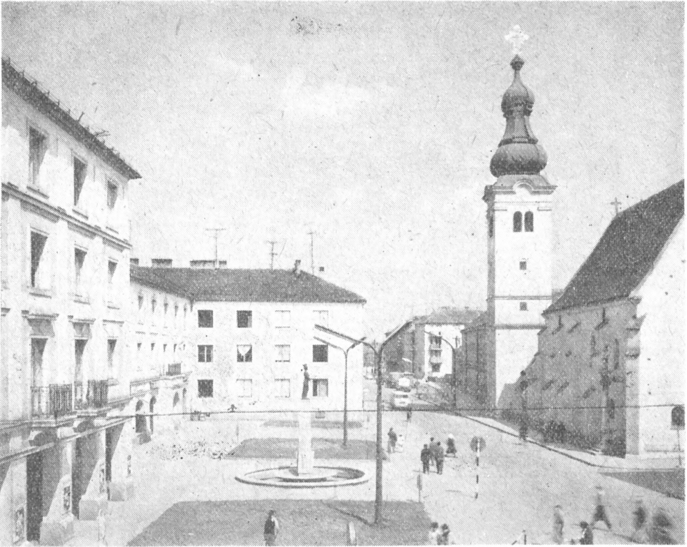
A Savaria tér. Balra új épületek — jobbra a helyreállított középkori templom
