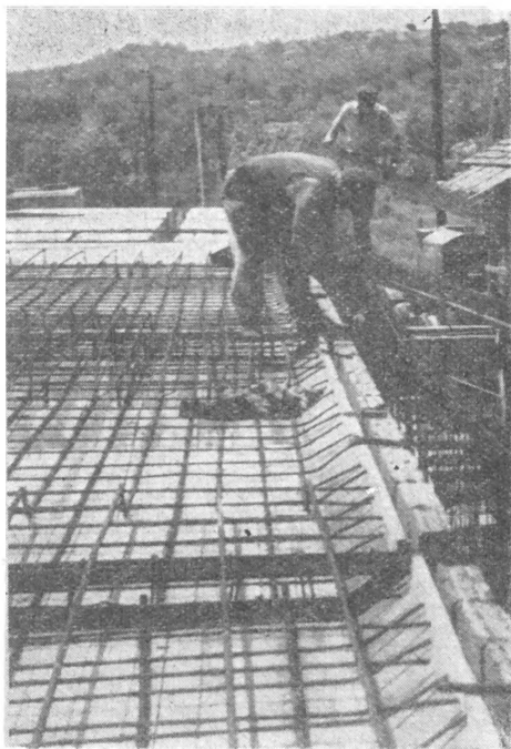
Az olvasótermi szint vasbeton szerkezetének szerelése
