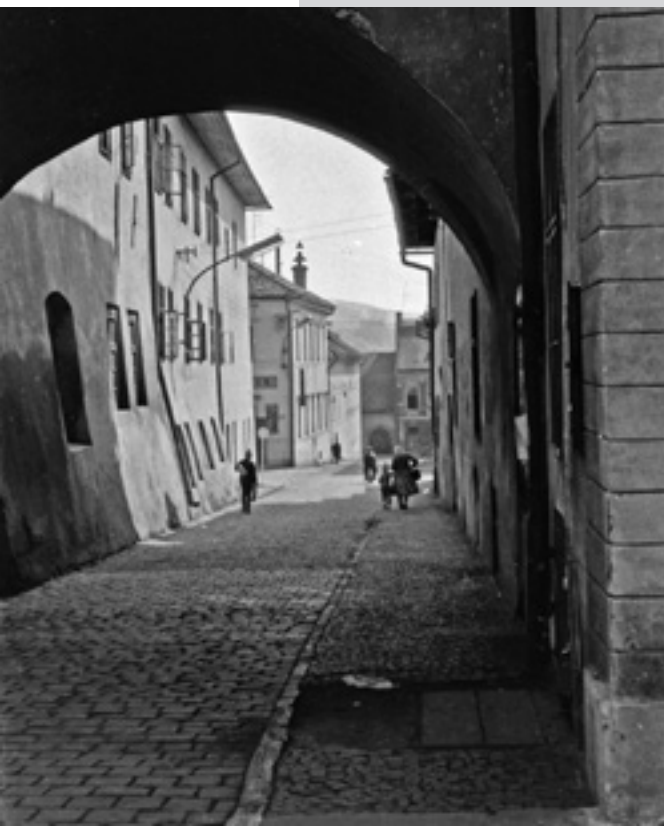
Lőcse, Sirovinská utca a főtér (Námestie Majstra Pavla) felől délkelet felé nézve
