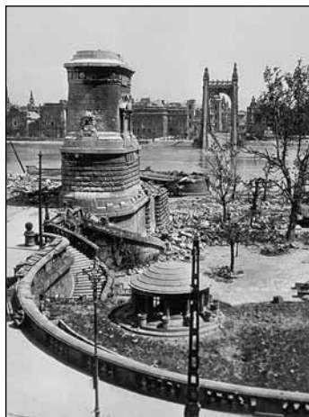
A lerombolt Erzsébet híd
