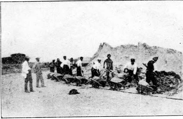
Képek a csepeli kikötő építéséről. Kubikusok talajgyegető munka közben.
