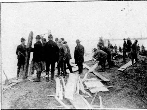
Gáterősítő munkálatok a vésztoi szakaszon.
