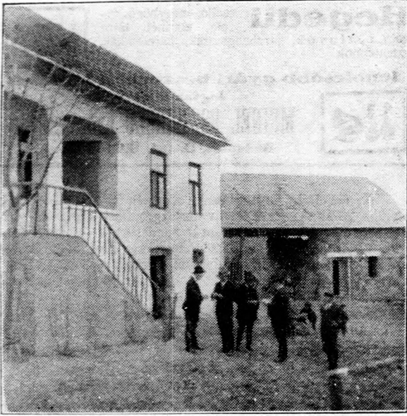
Bartók Nagy András sajméresei kigazda olasz mintájú háza. A tulajdonos új házat az olasz hadifogság alatt megfigyelt módra építette; földszinten vannak az istállók, emeleten a lakás.
