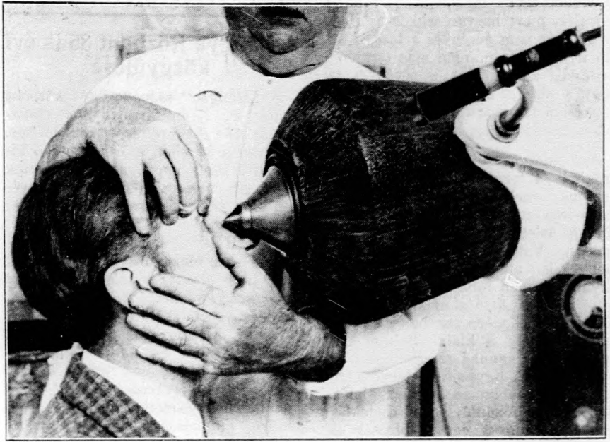
A világ legnagyobb orvosi célokra használt mágnes Bécsben, acélforgácsot, vasdarabkát vesznek ki vele a szemből.
