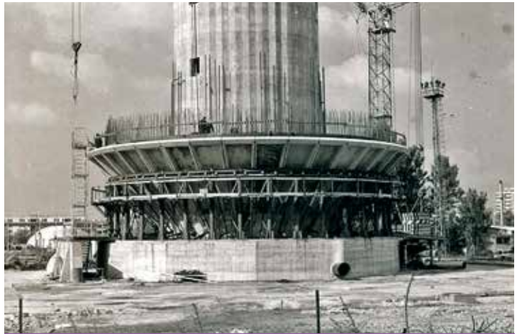
A víztorony építése 1983-ban
