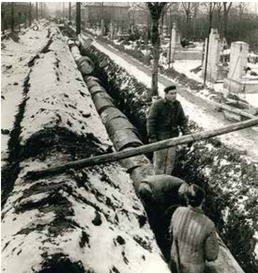
Szennyvízcsatorna építése az Iparvasút utcában 1962-ben
