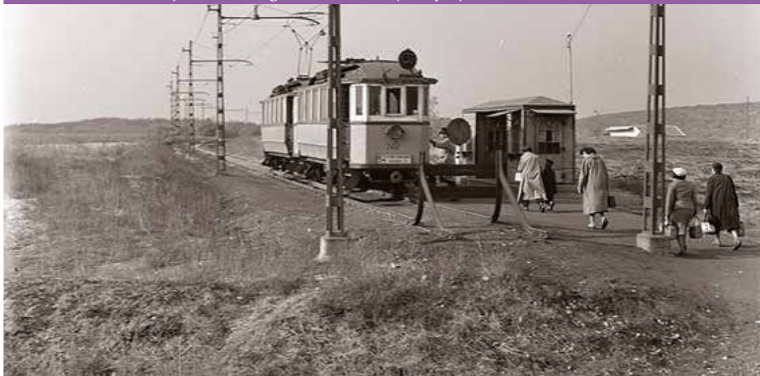
54-es villamos Pestimre felső vasúti megállónál 1959-ben (Fortepan)
