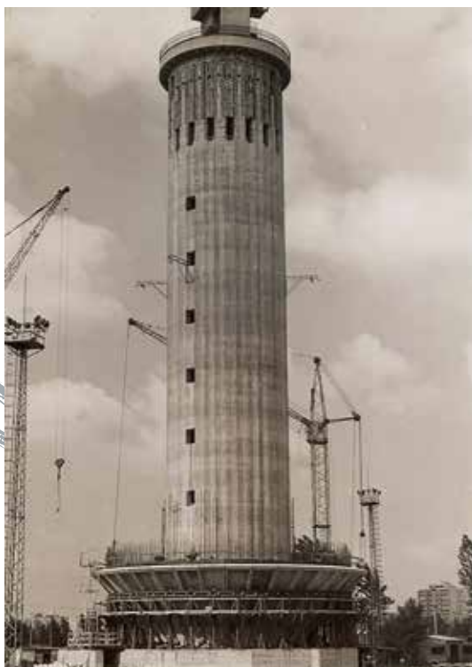
Az építés fázisai: A kehely összeszerelése...
