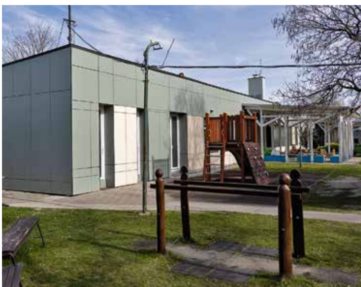
A nyílászárók és a szigetelés is megújult
