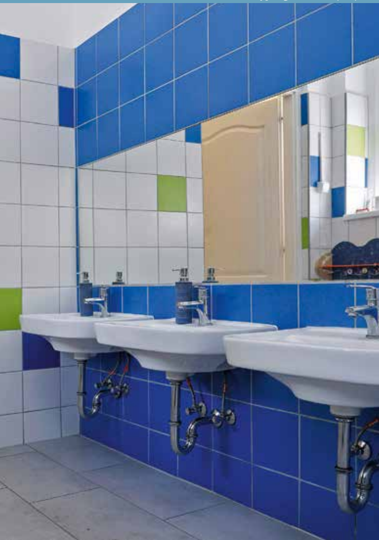
A Kísvackor és a Pity pang oviban is felújították a vizesblokkot
