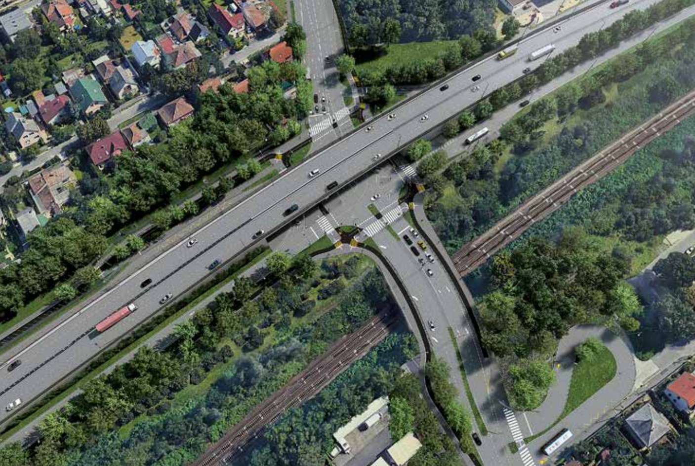
A Csévészó utcánál új felüljáró épül
