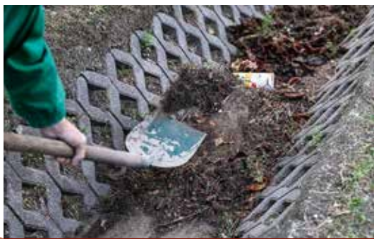
Az út menti nyílt árkok rendszeres takarítása segíti a lefolyó víz elvezetését
