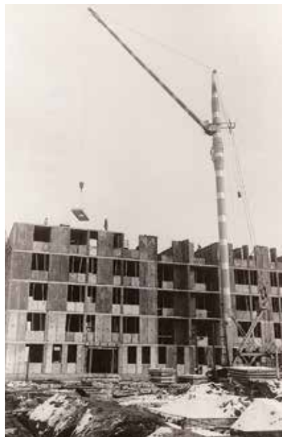
Négyemeletes ház építése a Lakatos-lakótelepen
