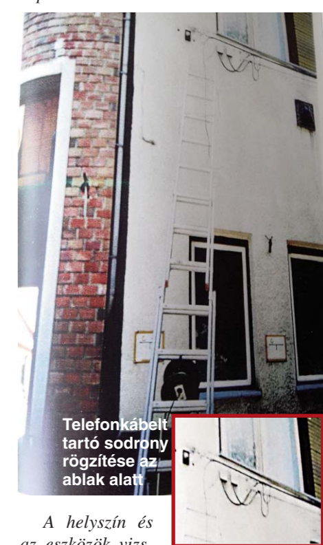
Telefonkábel tartó sodrony rögzítése az ablak alatt
