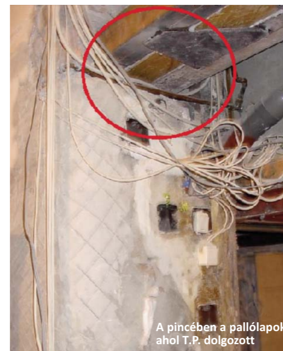
A feszültség alatti szigetetlen vezeték
