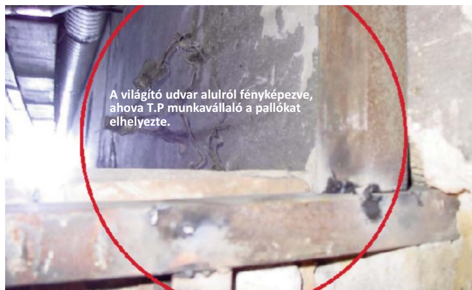
A világító udvar 3. emeletén a fürdőszobából kivezetett, porcelán csigára kötött ún. „GSV” vezeték, látható, hogy a porcelán csiga eltörtött, vezeték szigetelése levált.
