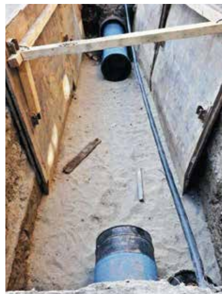
Budapest, III. kerület Dereglye utca – behúzott vezeték a csomópontban (2011)
