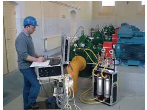
12. ábra Hidraulikai mérés a gyakorlatban (Kőbányai gépház, Ganz DAF 400 szivattyú és M3BP355 SMB 4B3 motor)
