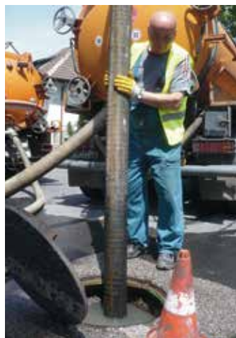
Árvíz által visszaduzzasztott szennyvíz kiemelése
