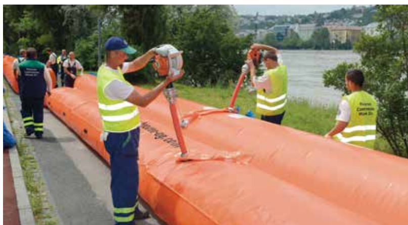
Óriás ikertömlős gát felállítása a Margitszigeten
