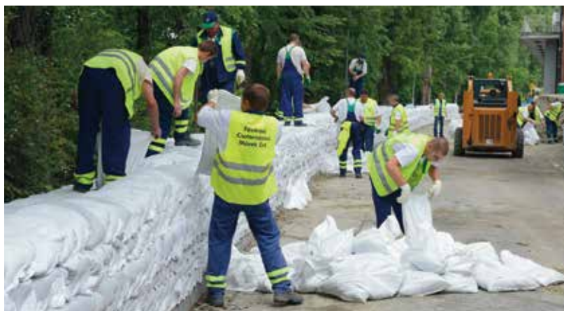
Ideiglenes gát építése a Margitszigeten
