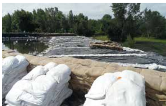
Csepeli szennyvíztelep, tisztított víz, ideiglenes túlfolyó műtárgy (épült 24 órán belül)
