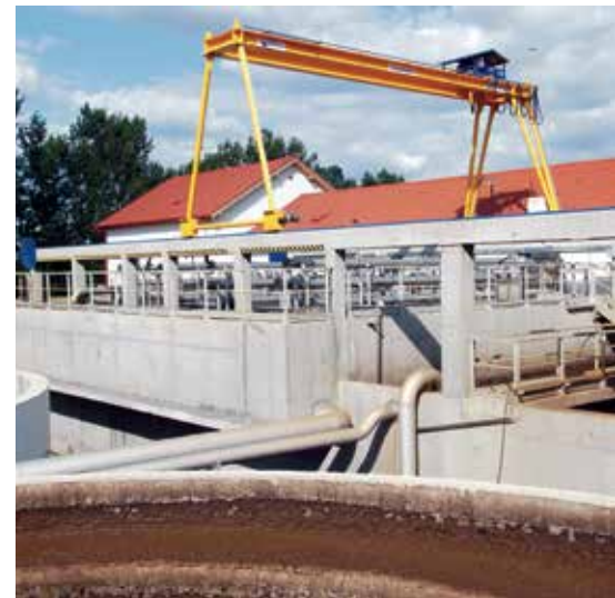
Veresegyház szennyvíztelep membrán medence a membrán kazetták kiemelését biztosító portáldaruval
