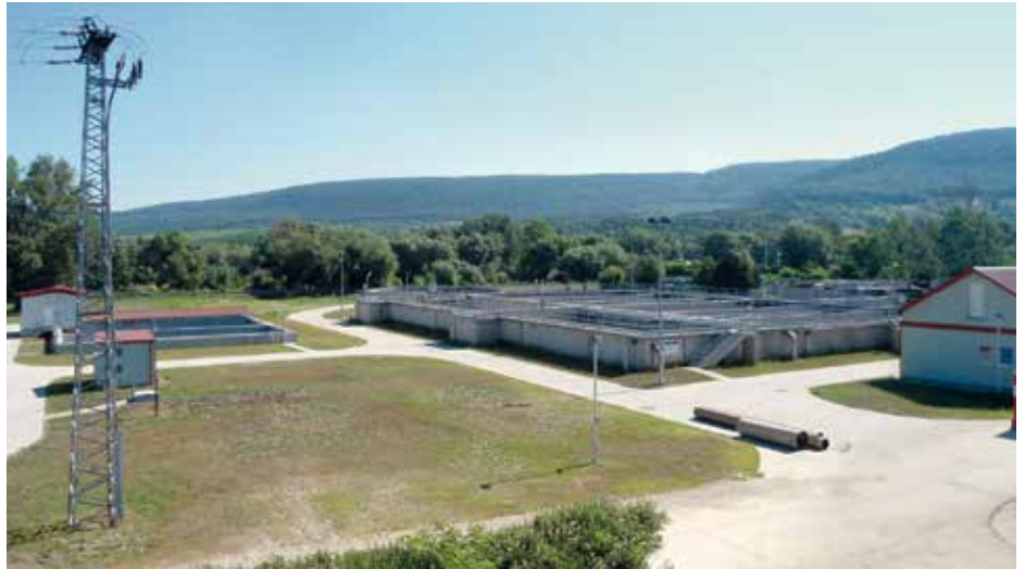
Új utódenitrifikáló tisztító rendszer, új oxikus medencék, új légfűvő gépház
