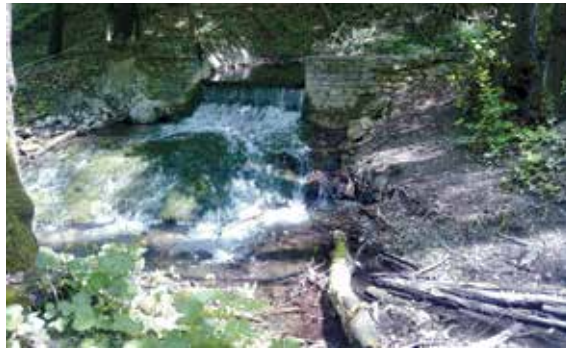
A természetes mederelágazásra kialakított, szabályozható vízelosztás
