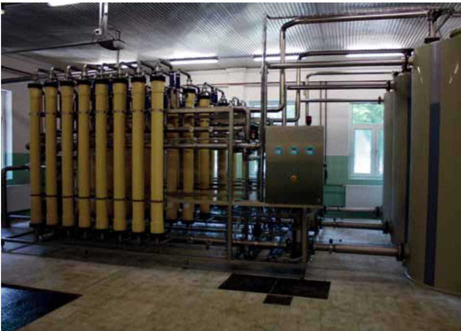
PALL Austria gyártmányú UF membránszűrő berendezés
