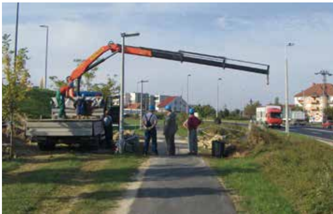
Nagy átmérőjű bekötés készítése Veszprémben
