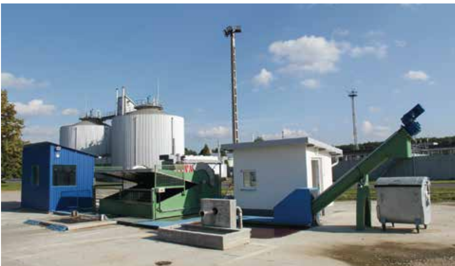
Hulladékfogadó állomás, Zalaegerszeg
