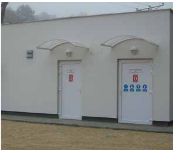
Veszprém-Aranyosvölgyi-víz-bázis újjáépített vízműgép-ház
