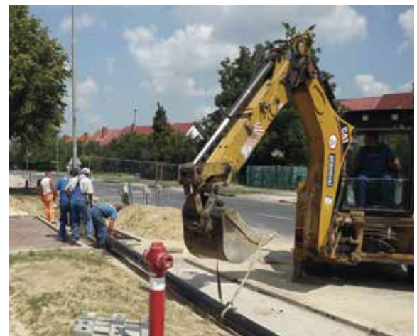
Vízvezeték rekonstrukció Veszprém Lóczy utcában
